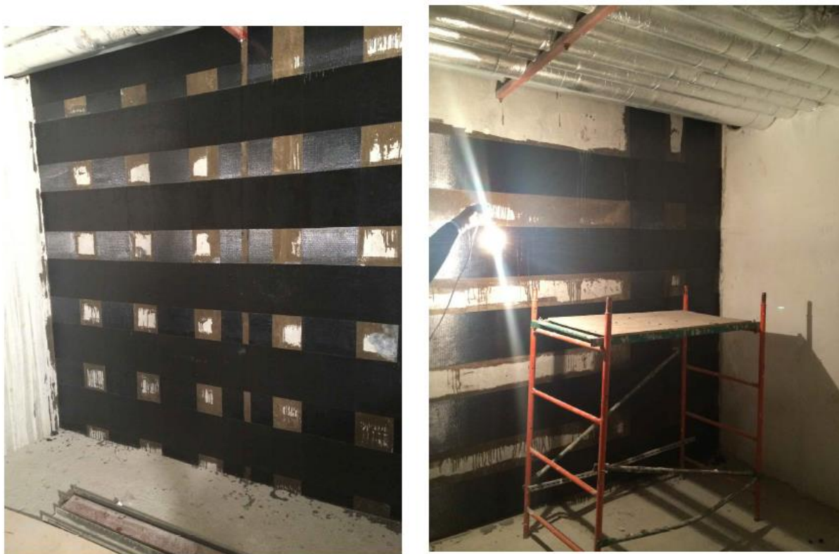
Рисунок 5.29 Пример усиления железобетонных стен
