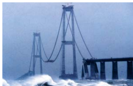
▲ Большой мост в Дании: служебная дорожка покрыта материалом Icosit® Elastomastic TF, который имеет повышенную механическую прочность и стойкость к ударам.
