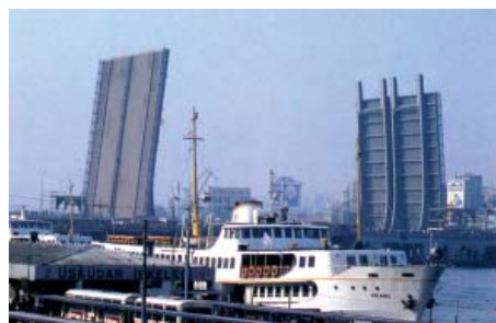
▲ Истамбул, Турция: створки нового моста защищены Icosit® EG System. Покрито всего 23.000 м 2
