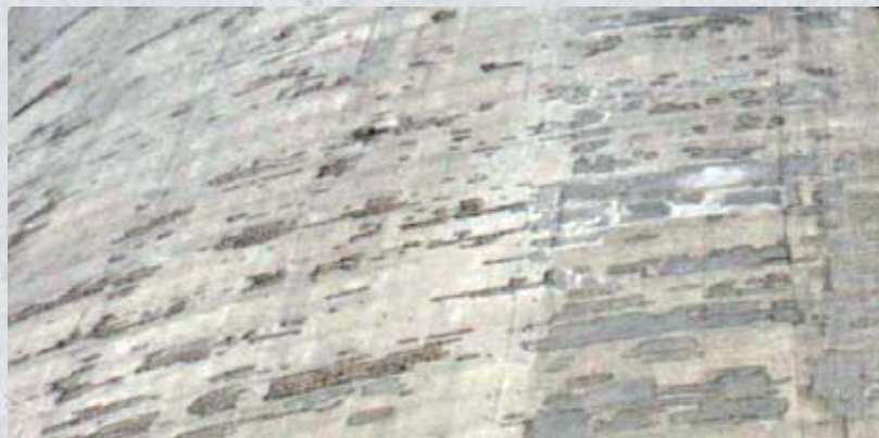
Локальный ремонт наружной поверхности большой градири, выполненный с помощью сухих смесей для ручного нанесения.
