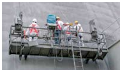
Нанесение выравнивающего раствора Sika® MonoTop 620 на предварительно отремонтированную поверхность бетона (локальный ремонт).
