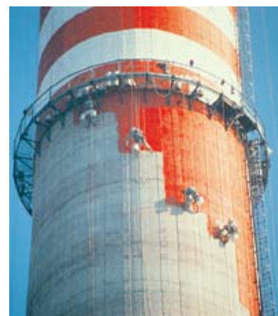
Промышленные альпинисты наносят Sikagard -680 S .
