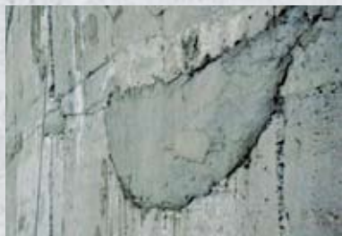
Ремонтный раствор Sika® MonoTop, нанесенный вручную.
