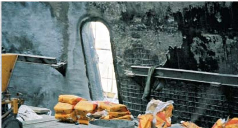
Оборудование SikaAliva для „сухого“ торкретирования в процессе нанесения SikaCem-Gunitite 133 внутри градирни.
