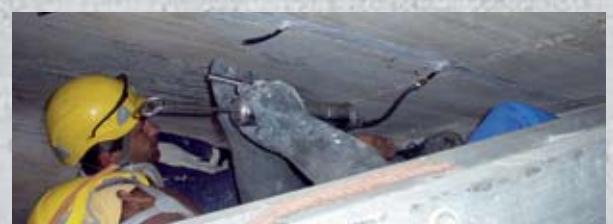
Инъектирование трещин.
