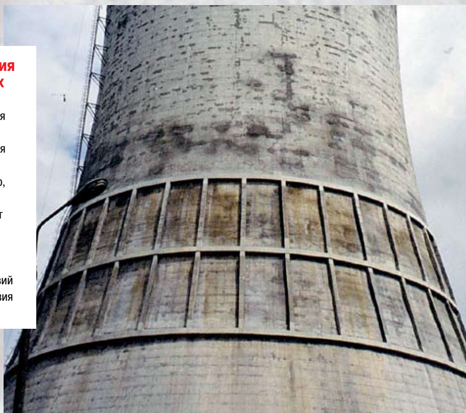
Ускоренная коррозия арматуры и эрозия бетона в зоне воздействия кислотных дымовых газов.
