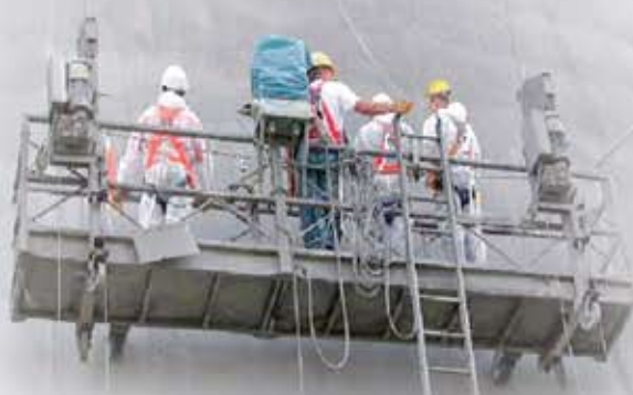
Специалисты по ремонту и защите бетона во время обследования поверхности градири.
