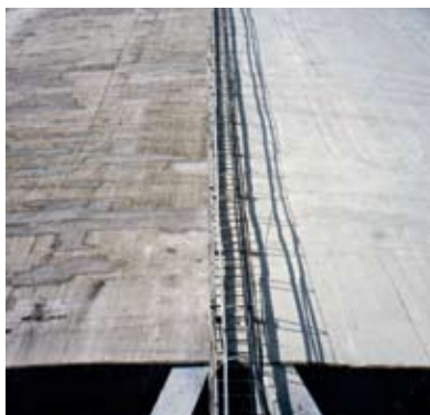
Локально отремонтированная поверхность. Слева – перед нанесением выравнивающего покрытия, справа – после нанесения выравнивающего покрытия.
