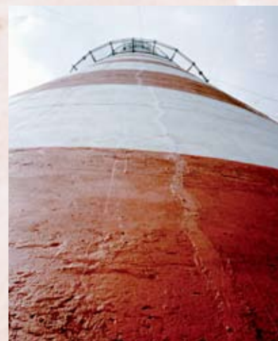
Герметизация трещины герметиком Sikaflex® с последующим нанесением защитного покрытия SikaGard®-680 S .
