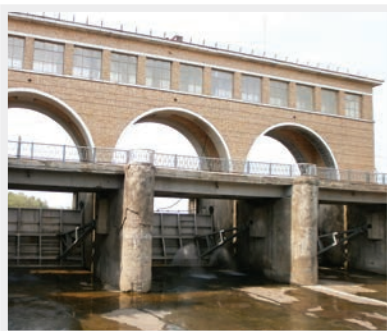
Общий вид сооружения до начала работ
