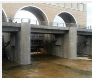
Окончательный вид сооружения после ремонта
