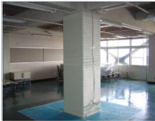
Сейсмоусиление колонн школьного здания (Япония)
