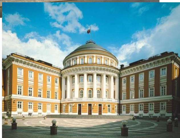
Здание №1 Московского Кремля
