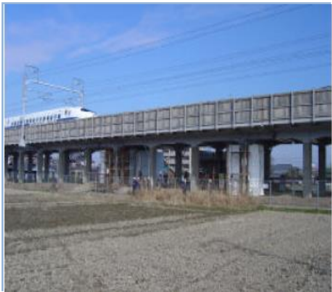
Сейсмоусиление эстакад скоростных поездов (Япония)
