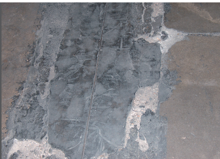
фото 20 Разрушенный бетон
