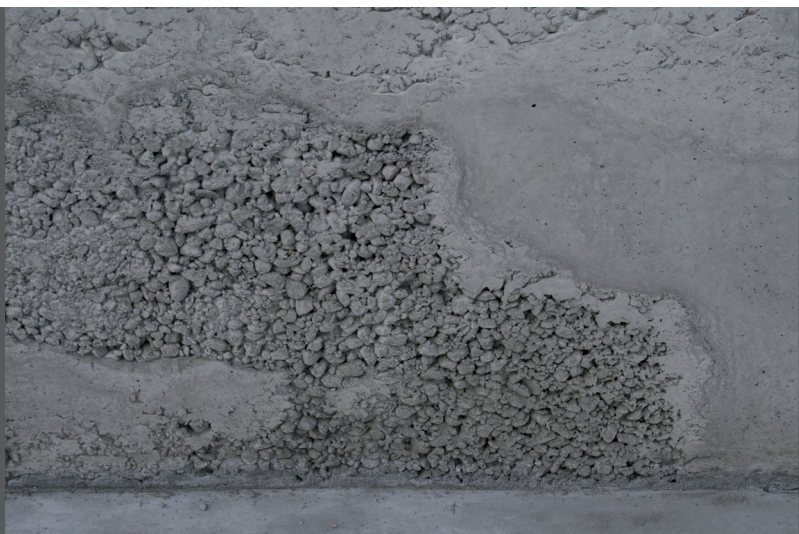
фото 21 Разделение заполнителей в бетоне
