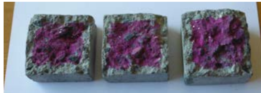
Фото 12. Внешний вид контрольных бетонных образцов (без покрытия) после 14 суток испытаний
