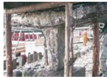
Рис. 3. Разрушение бетона маломассивной опоры с оголением и коррозией арматуры
