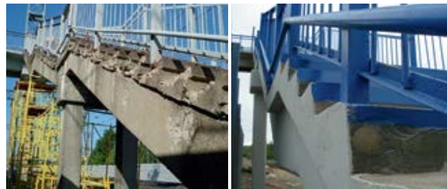
Рисунок 5.2. Пешеходный мост через железнодорожные пути на ст. «Полянки» Ярославской железной дороги. Материалы: Mapegrout Thixotropic, АРБ 10, окраска Colorite Beton.
