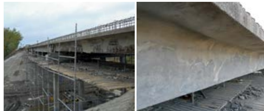
Рисунок 5.2. Путепровод автодороги Ярославль-Суздаль, 11-й км. Материалы: Mapegrout Thixotropic, Mapefer 1K.
