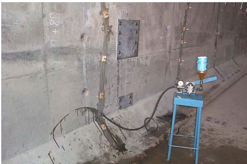
Рис. 33. Инъектирование трещин по высоконапорной технологии
