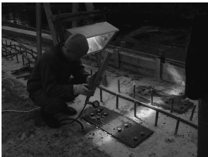
Рис. 38. Инъектирование трещины ручным насосом
