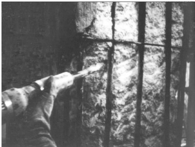
Рис. 13. Подготовка поверхности с помощью бучарды
