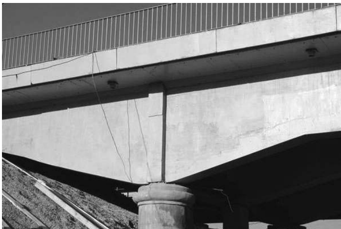
Рис. 27. Отремонтированное пролетное строение
