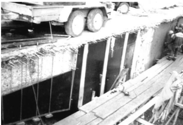
Рис. 25. Нанесение ремонтного состава методом набрызга: а) нанесение состава; б) выравнивание слоя раствора после набрызга
