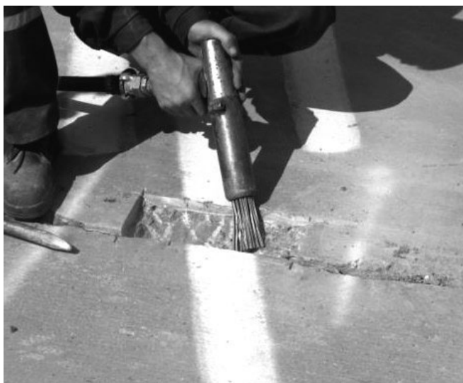
Рис. 14. Подготовка бетона игольчатым пистолетом
