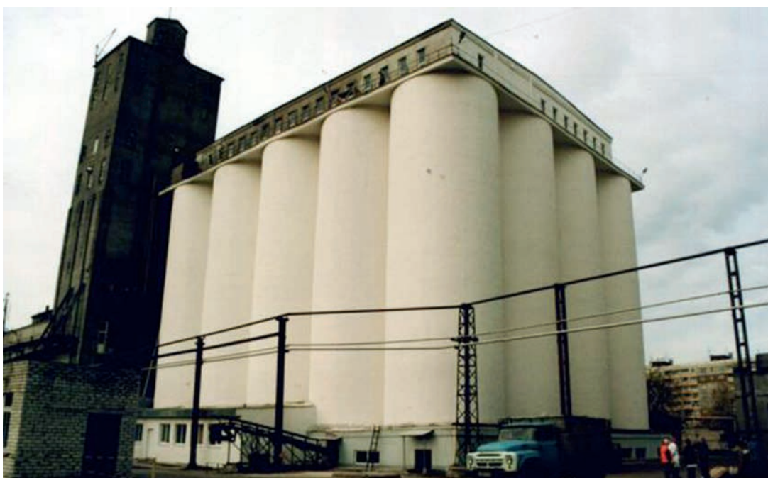
Рисунок 4.2.2 – Элеваторный (силосный) корпус
