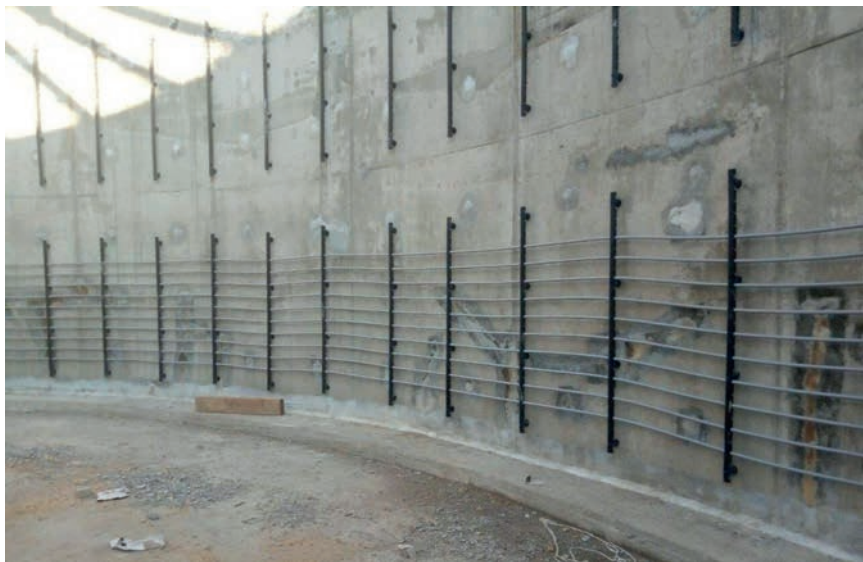
Рисунок 4.5.6 – Трубы подогрева биомассы внутри биореактора
