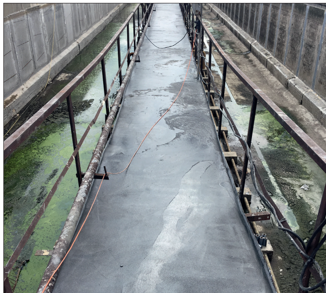
Рисунок 17 – Ремонт плит переходных мостиков (соотношение по массе: «Скрепа М600 Инъекционная»:Песок = 1:1)
