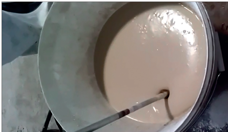
Рисунок 25 – Приготовление растворной смеси «Скрепа 2К Эластичная»
