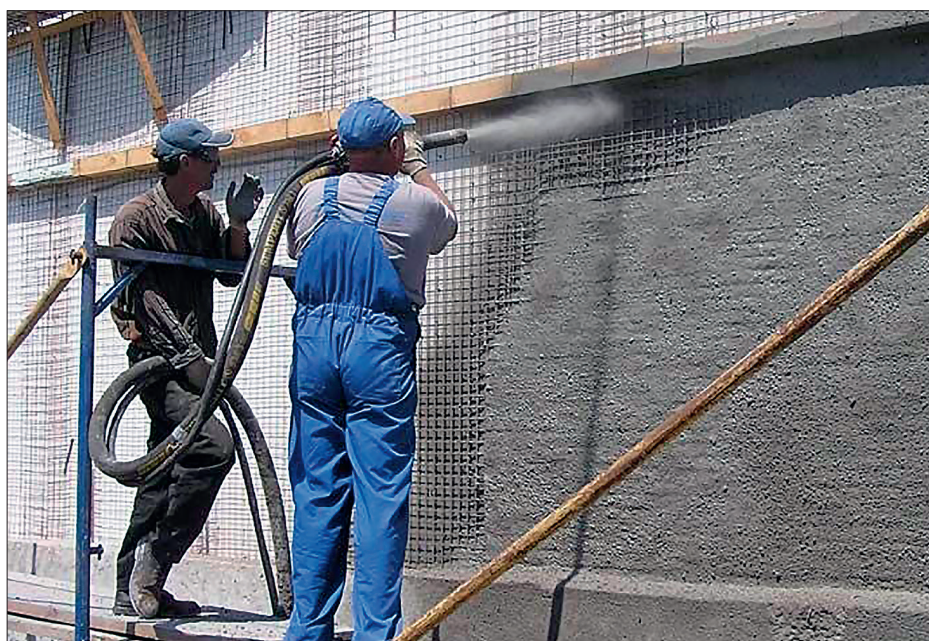
Рисунок 21 – Сухое торкретирование
