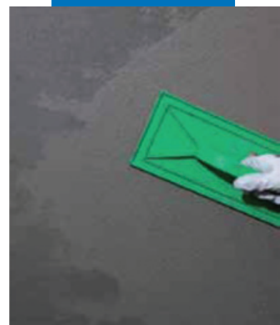
Трамбовка Mapegrout 230
