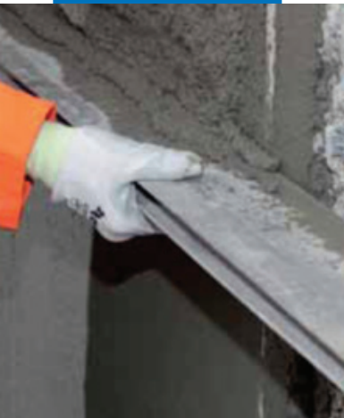
Выравнивание Mapegrout 230 при помощи правила
