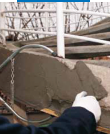
Нанесение Mapegrout 230 при помощи мастерка
