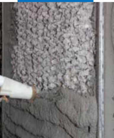
Нанесение Mapegrout 230 набрызгом
