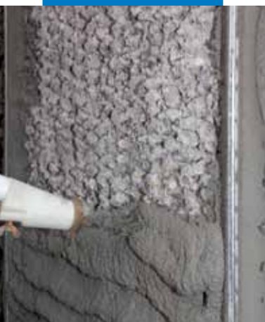
Нанесение MapegROUT 430 набрызгом
