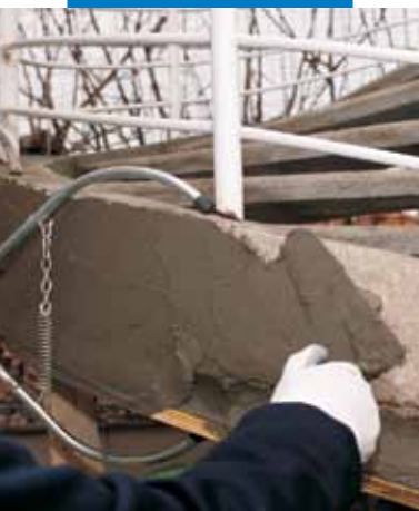
Нанесение MapegROUT 430 при помощи мастерка
