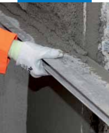
Выравнивание MapegROUT 430 при помощи правила
