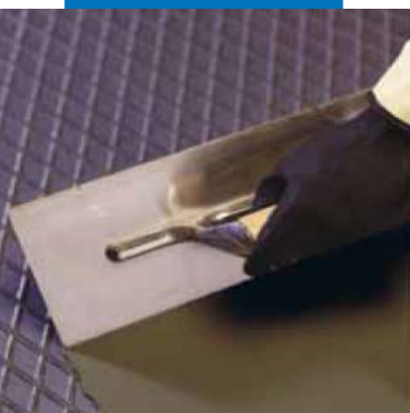
Планипатч смешанный с Admix I для выравнивания металлических оснований
