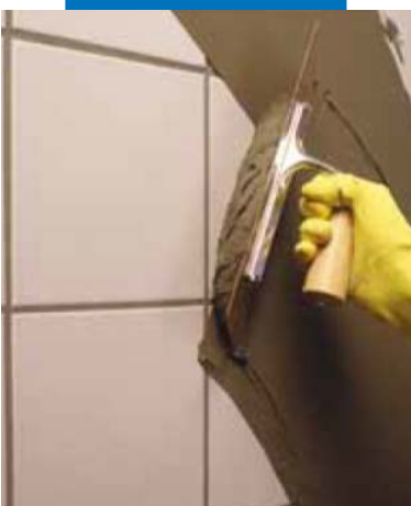
Выравнивание существующей облицовки составом Планипатч
