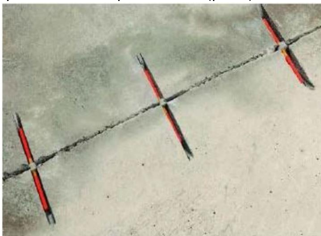
Рисунок 7. Установка стяжек в каналы, открытые в трещинах
