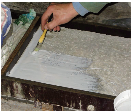
Рисунок П3 Нанесение адгезионного состава марки Eporip на поверхность бетонного основания
