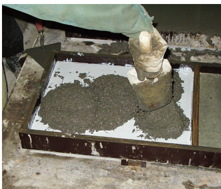
Рисунок П4 Укладка ремонтного материала АРБ-10Ф
